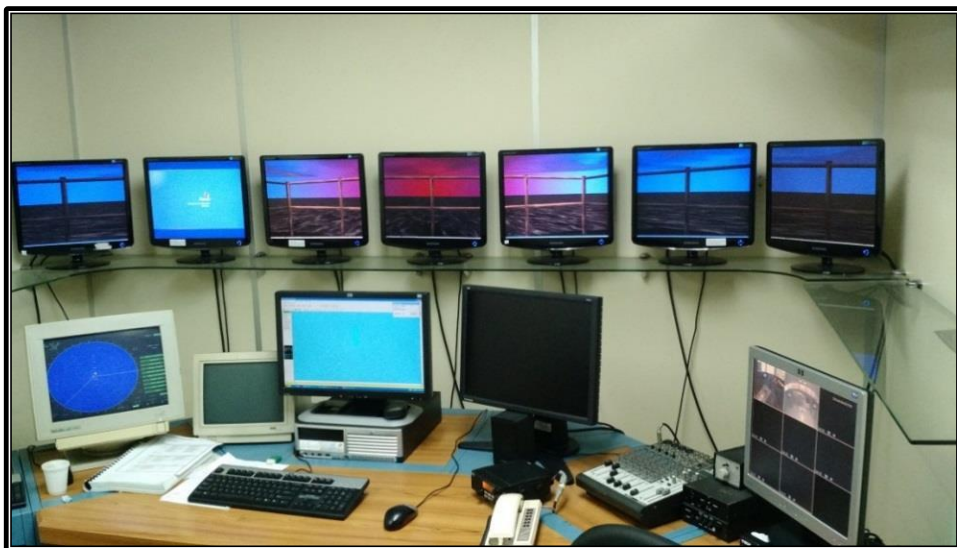
Figura 15: Sala de Controle
